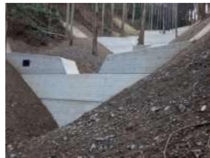
復旧治山事業 谷止工
