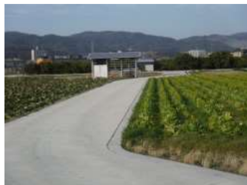
農作業道整備
