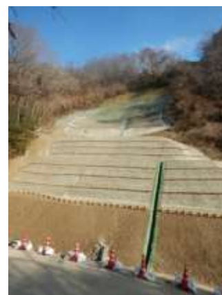
県土防災対策治山事業 土留工、緑化工
