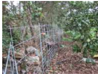
補助事業を活用し 防護柵を設置
