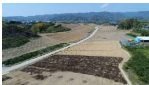
施工中の「ほ場整備」下丹生谷地区
