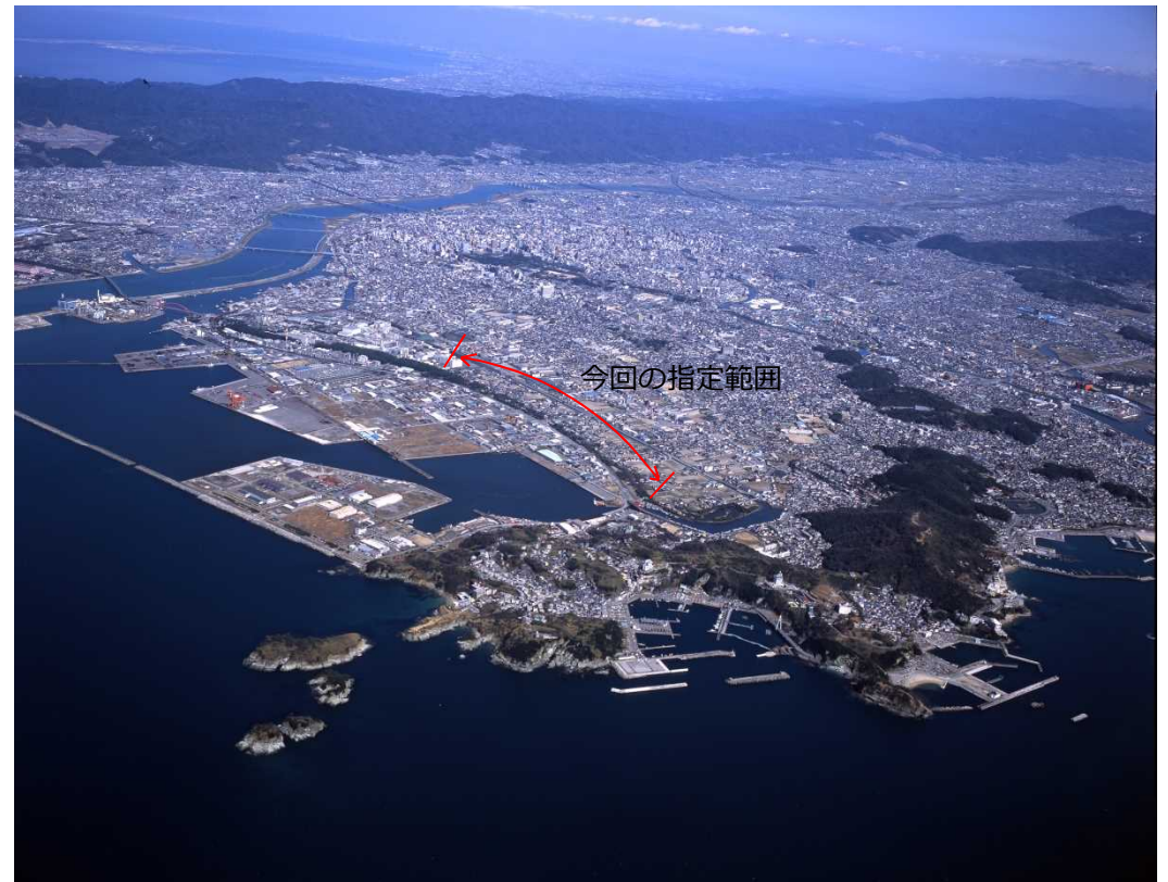
水軒堤防 航空写真
