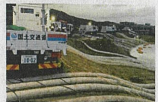
排水ポンプ車による緊急排水
