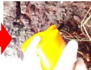
排糞孔にノズルをさし、薬液を注入する
