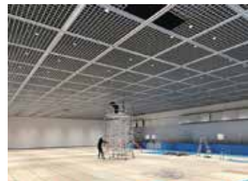
10. 2階展示室照明工事の様子（2020年）
