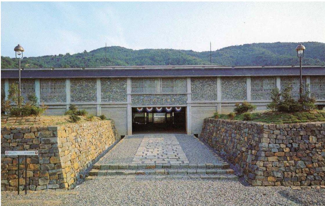
竣工時の写真
