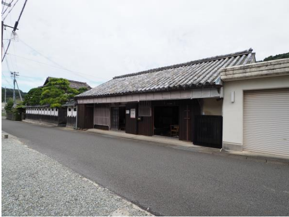
1. 一木旅館 南より見た全景
