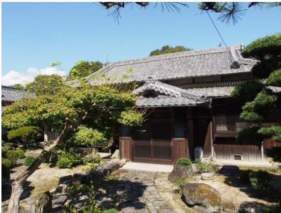
3. 上田家住宅 主屋 正面全景
