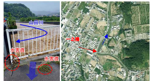
R5.6豪雨で氾濫した一之橋付近
