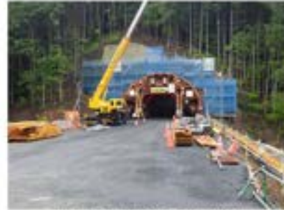
② すさみ町里野(中平見トンネル)
