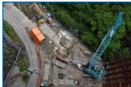
P1の施工状況（場所打ち杭）
