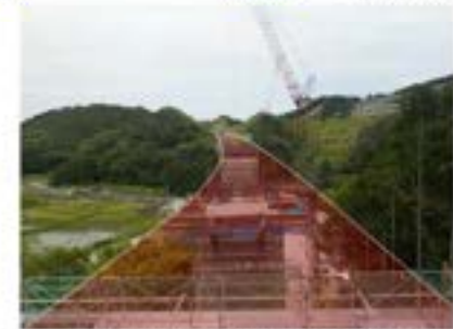
⑧ 串本町サンゴ台(サンゴ台高架橋)
