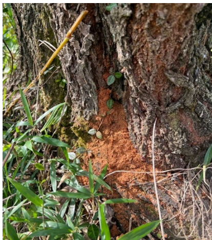
被害（フラス）の発生状況
