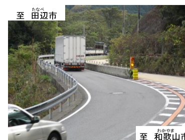
写真③ 平面線形不良箇所
